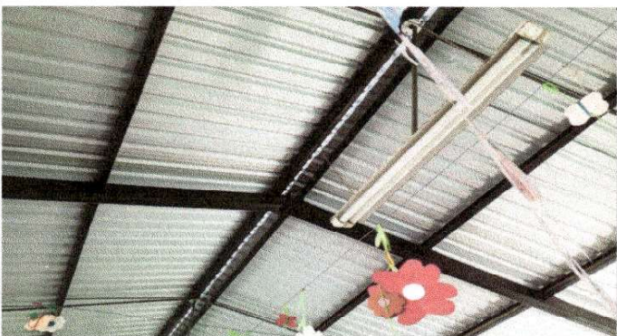
Foto 3: Culminación de colocación de costanera e intacción de lámparas
