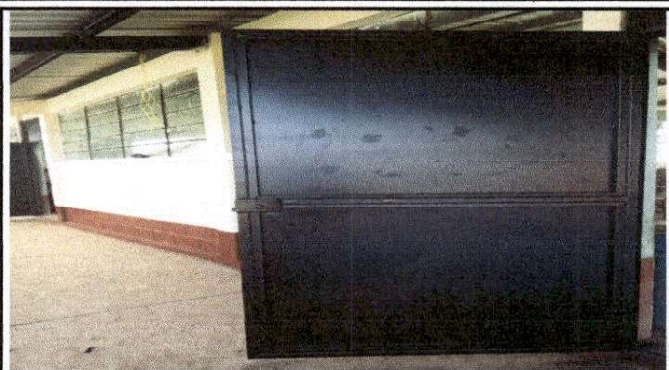
Foto 2: terminado la remodelación de puertas
